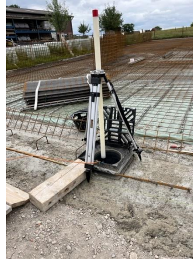
Dichtheitsprüfung einer unterirdisch verlegten PE-HD Rohrleitung
