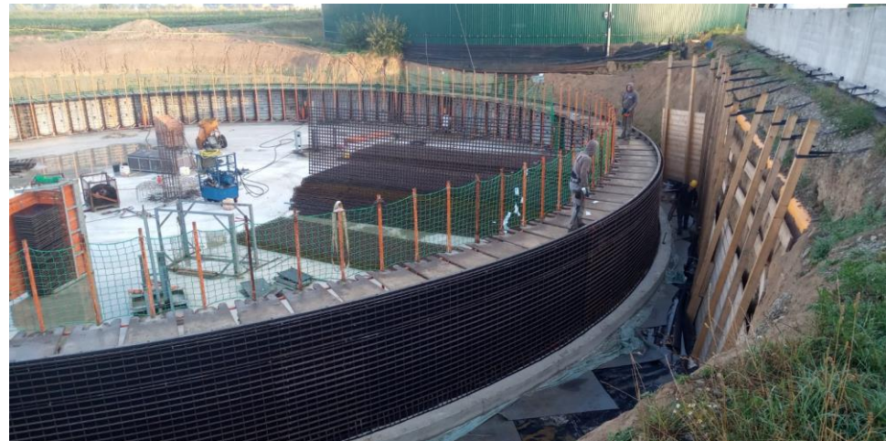
Bau eines Gärrestlagers
