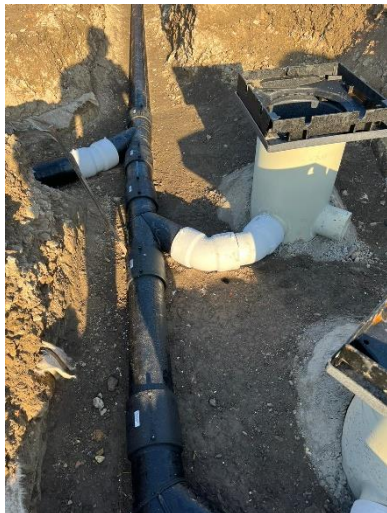
Schächte aus PE bzw. PP mit Gussaufsatz
