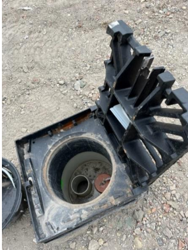
Trennschacht Aqua Clean GmbH DIBt-Zulassung Z-40.23-576 mit Gussaufsatz
